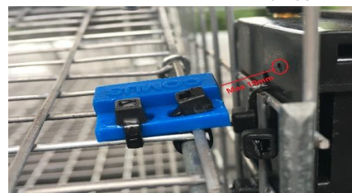
Afstanden mellem magneten og det lille hul i beslaget, må max være 10mm.
