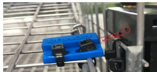
Afstanden mellem magneten og det lille kontrolhul i beslaget, anbefales max at være 10mm.
